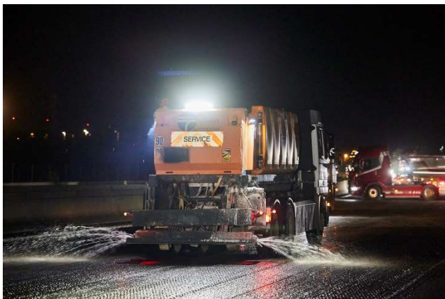
Nettoyage de la chaussée par balayeuses à haute pression
