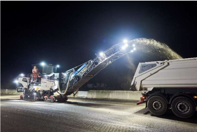
Rabotage de l'ancienne chaussée
